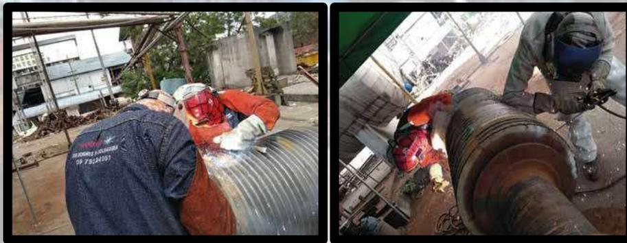
Dentro del procedimiento de soldadura usamos para la reparación y mantenimiento nuestras técnicas como el CHAPISCO que consiste en la aplicación del consumible en los flancos de las masas que genera, depositando así también la técnica de PERLEADEO que es la aplicación de material en la cresta de la masa, aumentando así la capacidad de tracción y en consecuencia produciendo una mayor extracción de jugo
